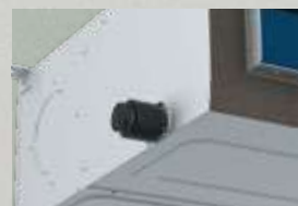
Вывод дренажа с двух сторон
